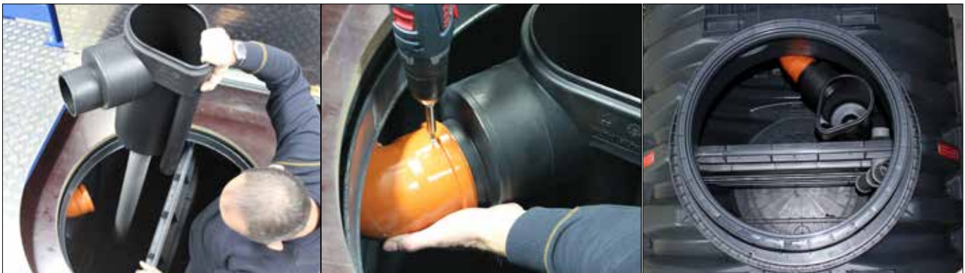
- Einsetzen der Probenahme mit dem Stützfuß
