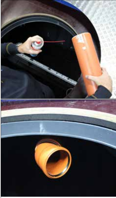
- Einbau des Ablaufrohres
